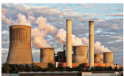
原子力発電所
